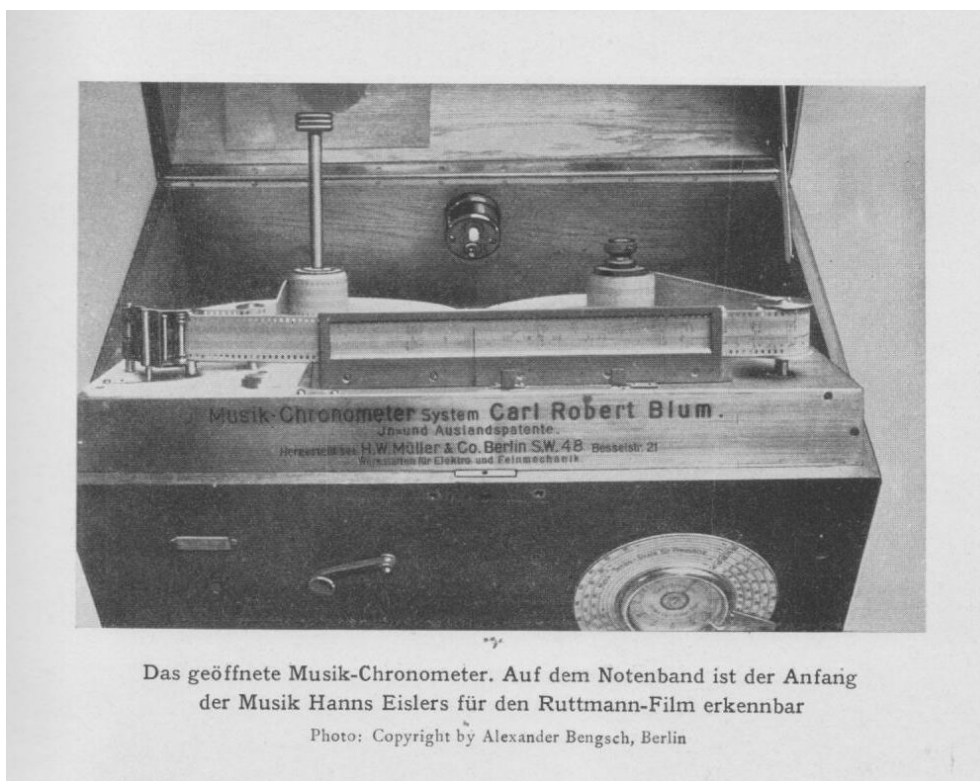
Abb. 4: Das Musikchronometer. Auf dem Notenband ist der Anfang der Musik Hanns Eislers für den Ruttman-Film erkennbar.
